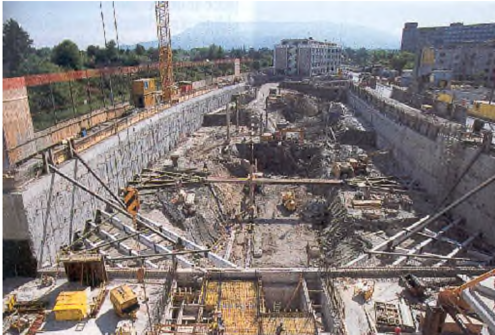
Terrassement en cours – fond de fouille atteint au centre A gauche : voie ferrée Genève Eaux Vives - Annemasse
