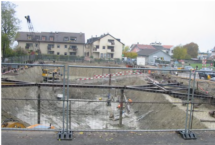
Vue générale de la fouille avec merlons de terres contre la paroi.
