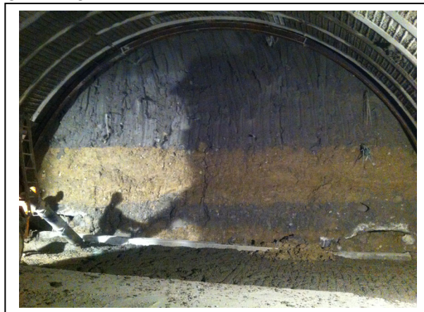
Photo 1 : Excavation voûte coté Bachet
