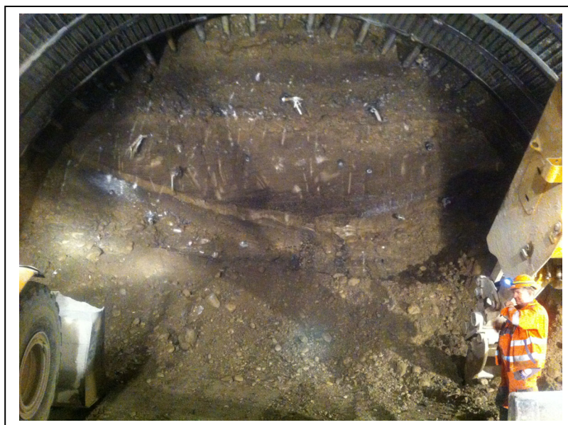
Photo 2 : Excavation PT 7 coté Voirie
