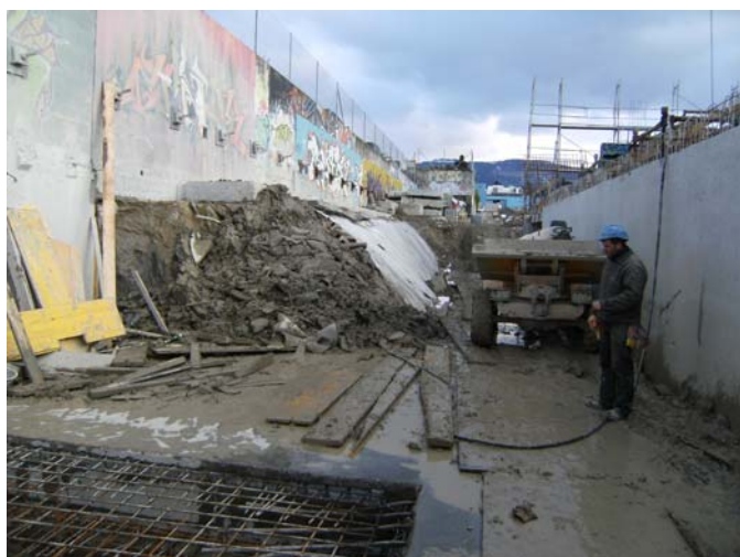
Photo : Travaux de terrassement en sous-œuvre par étapes avec mur périphérique existant ancré.
