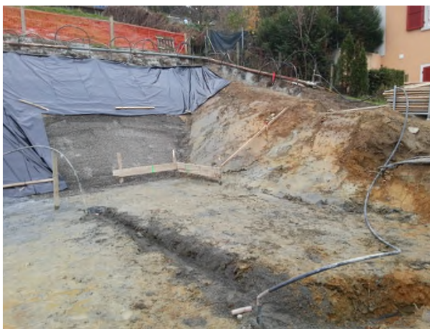
Renforcement du pied de talus
