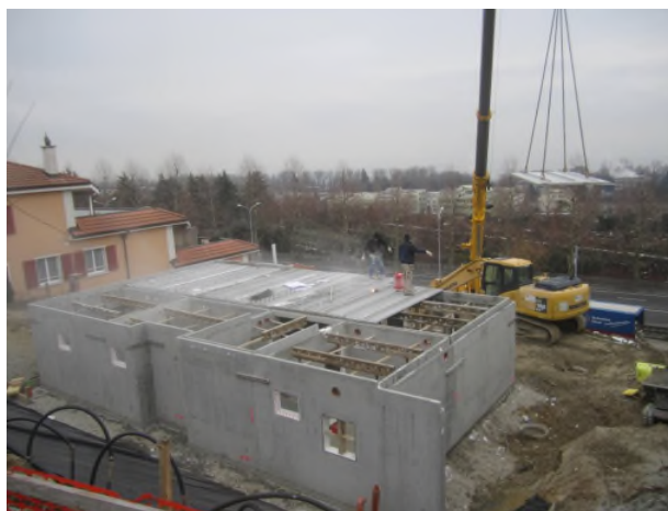
Montage des éléments préfabriqués
