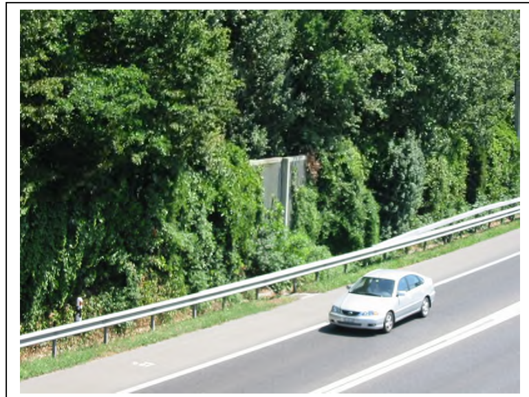
Murs paraphones disparaissant sous la végétation
