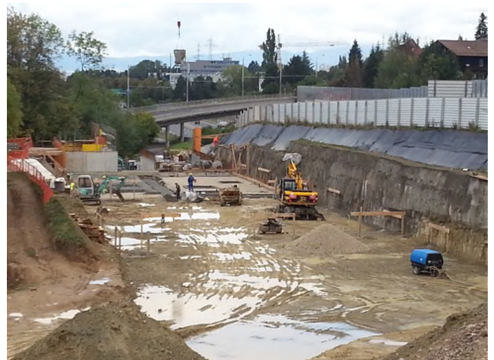
Fouille en pleine masse
