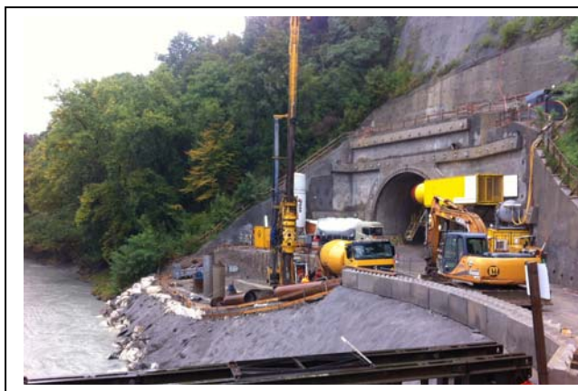
Photo 2 : Pont provisoire, entrée du tunnel de Champel et forage des pieux de la culée Champel
