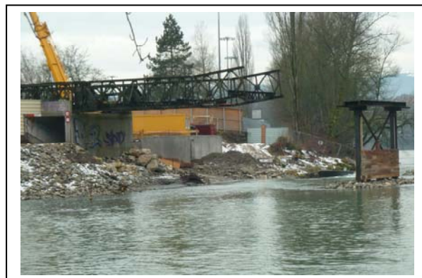
Photo 1 : Poussage du pont provisoire
