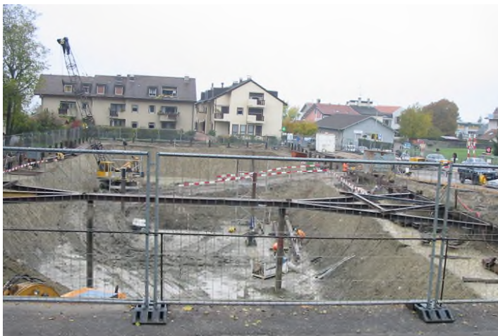
Vue générale de la fouille avec merlons de terres contre la paroi.
