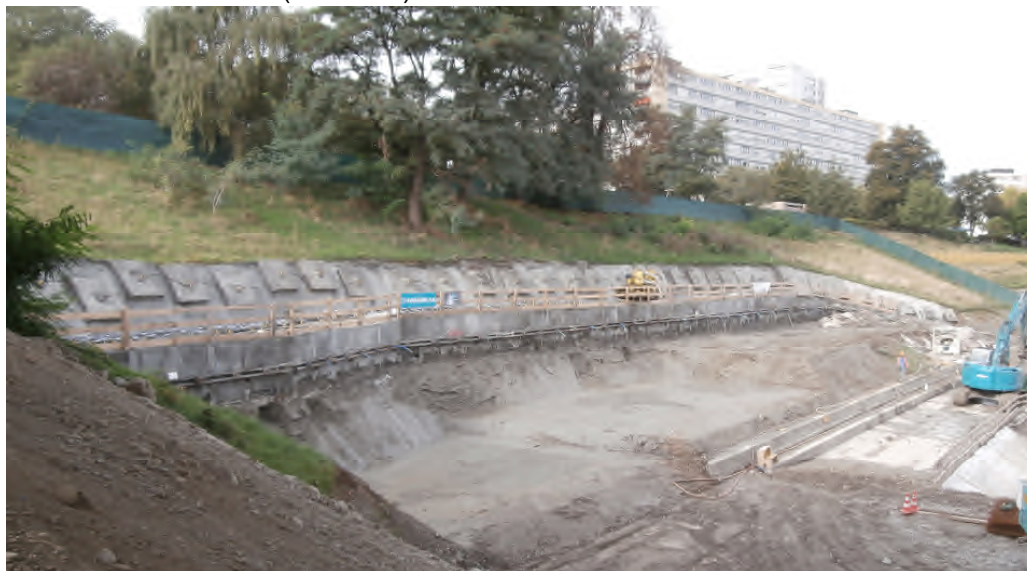
Photo 2 : Talus ancrés et berlinoises (1 er rang)
