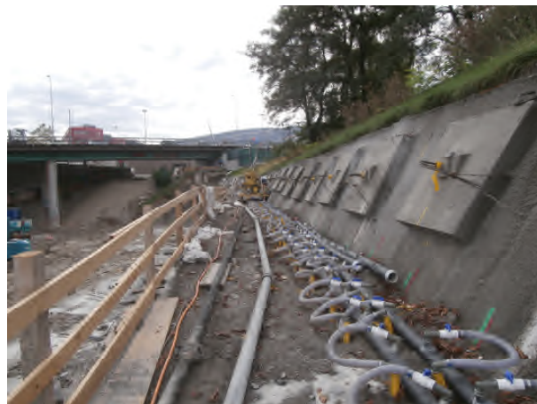
Photo 1 : Well points et plaques ancrées
