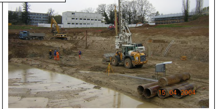
Forage de pieux pour la reprise des efforts de séisme
