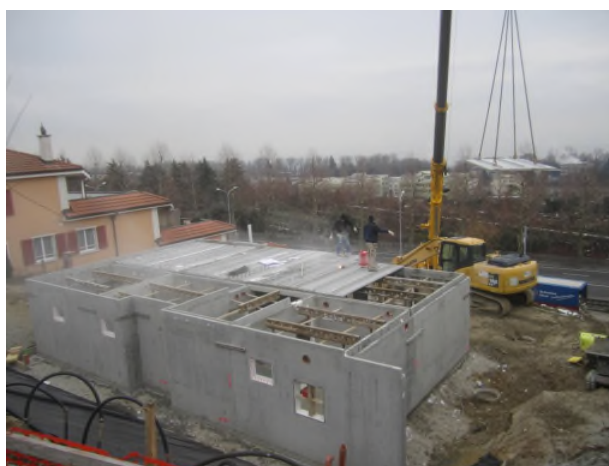
Montage des éléments préfabriqués
