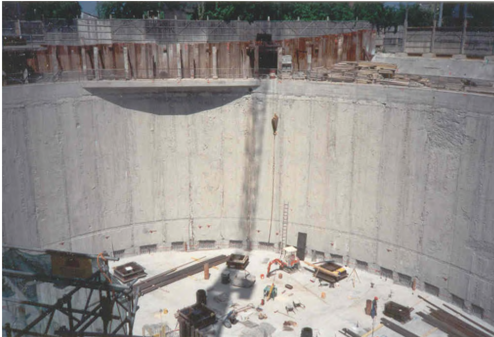
Enceinte elliptique en parois moulées – Terrassement terminé Derrière la palissade : voie ferrée Genève Eaux Vives - Annemasse
