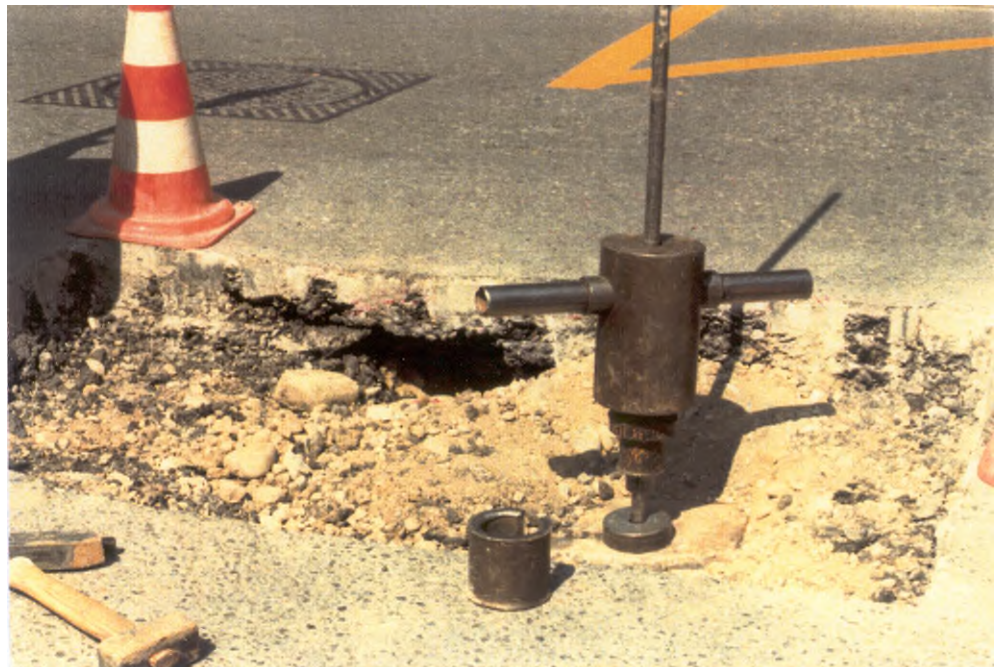
Contrôle du compactage au pénétromètre
