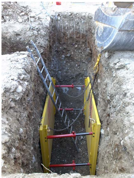
Photo 1 : tranchée en cours d'exécution ; les graviers perméables apparaissent dès 2 m de profondeur environ
