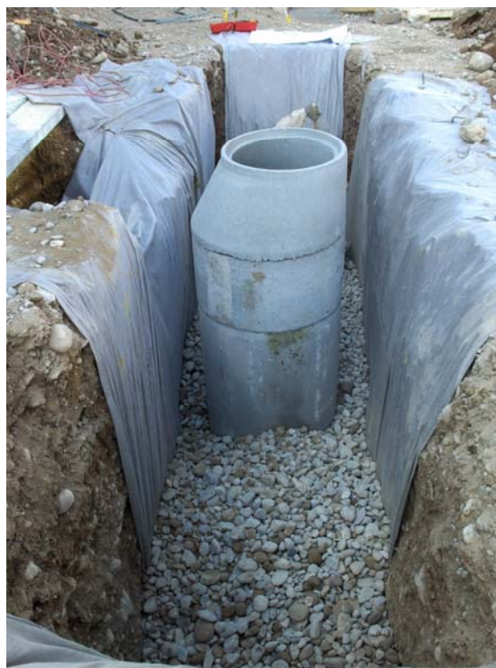
Photo 2 : mise en place de la chambre centrale et des boulets dans la tranchée.
